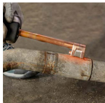
Uklanjanje ispušnih cijevi
